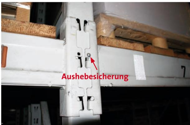
Abb. 13: Fehlende Aushebesicherung
